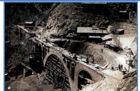
Bildarchiv der Philipp Holzmann AG: Unfertige Brücke in der großen Schlucht der Taurus-Strecke, Bagdad-Bahn
